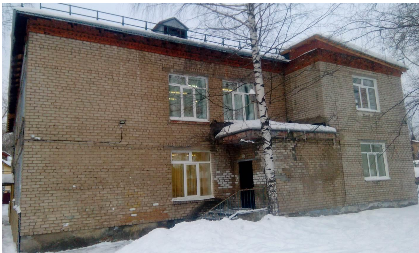
Фото 4. Фасад здания в осях 6/А-В.
