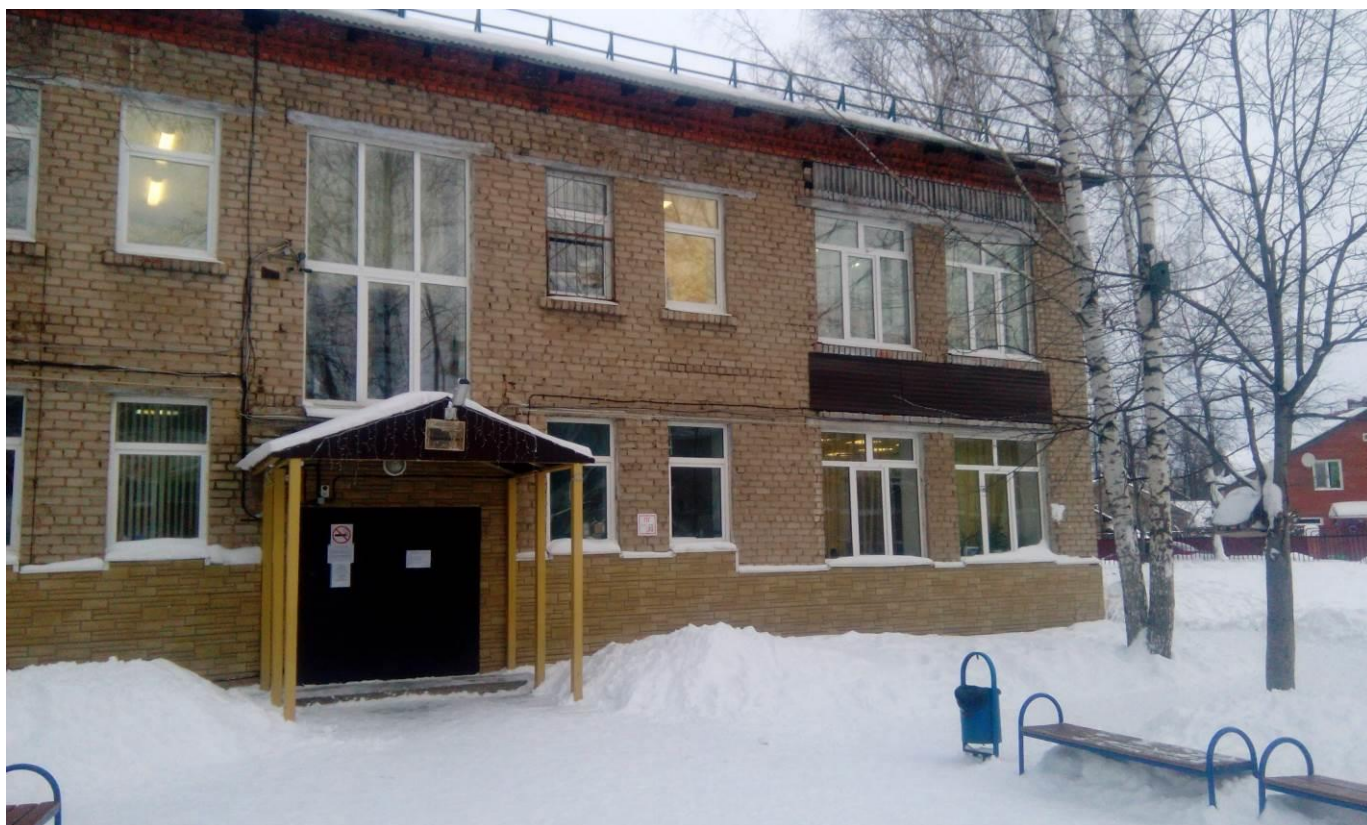
Фото 2. Фасад здания в осях 3-6/А.
