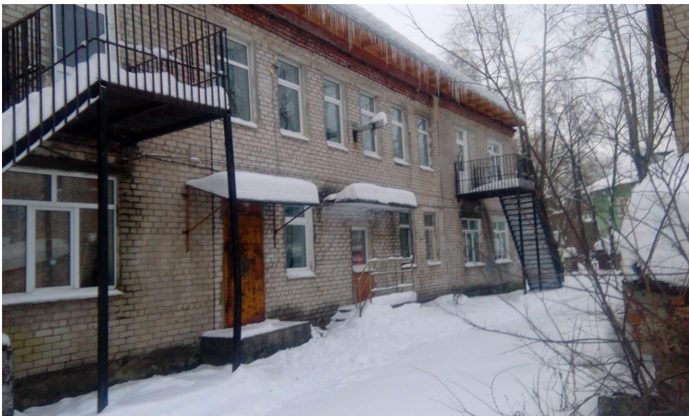
Фото 5. Фасад здания в осях 5-1/В.
