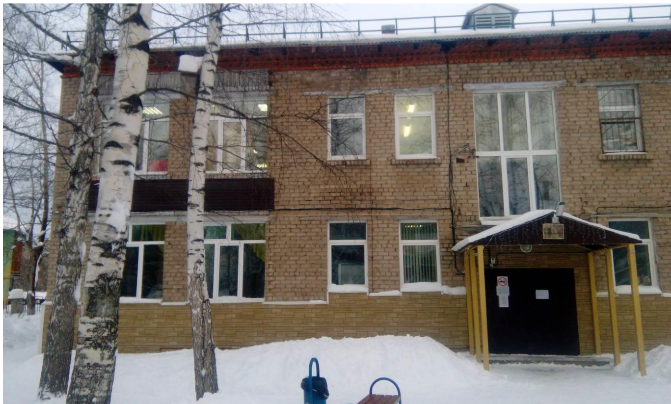
Фото 1. Фасад здания в осях 1-4/А.
