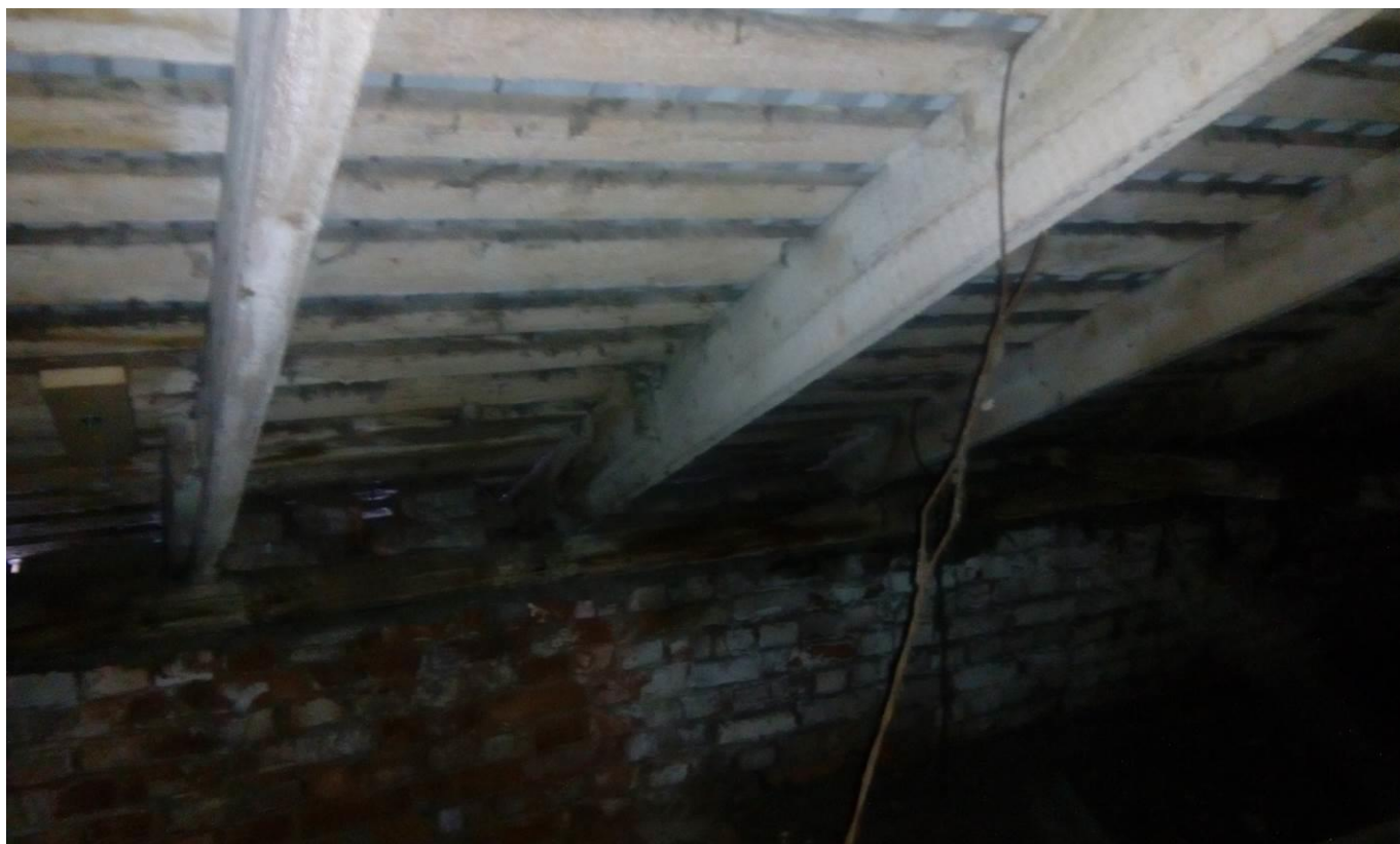
Фото 16. Общий вид стропильных конструкций кровли.
